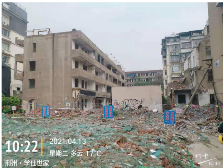
图一事故发生房屋拆除施工工地
